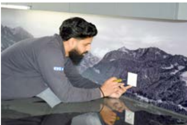
Der elektrotechnische Feinschliff an der Küchenzeile mit hiesigem Bergpanorama.
