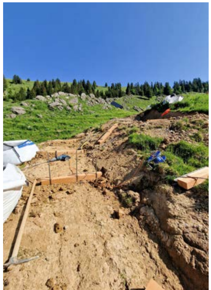
Die mit Lärchenholz erschaffenen Tritte wurden mit langen Armierungseisen verankert.
