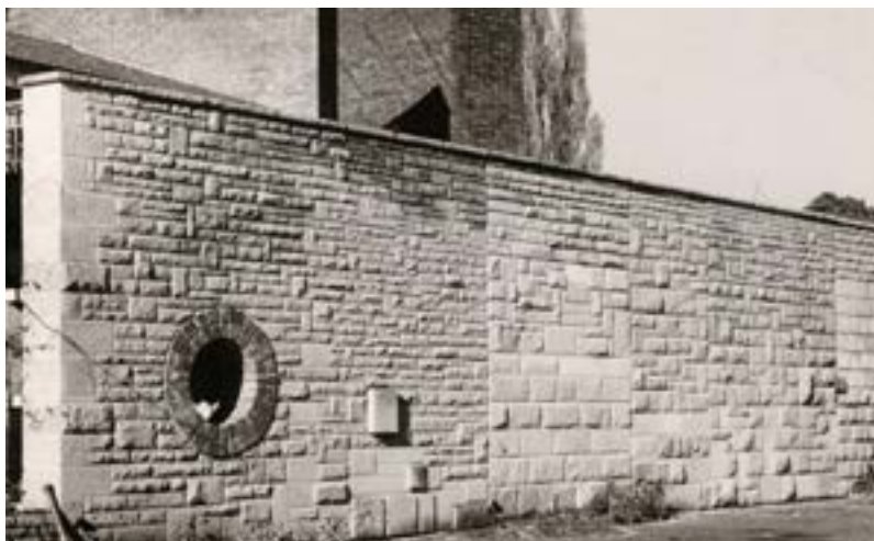
Referenzmauer aus Benkner Sandstein an der Landi 1939 in Zürich.
