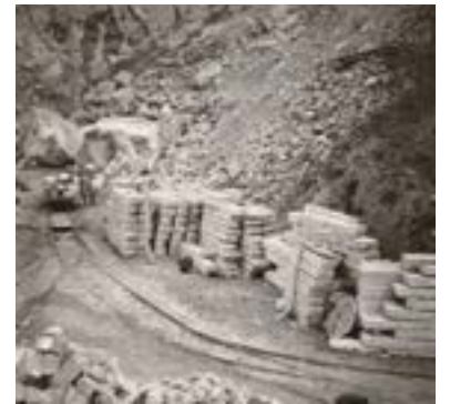
Mit Rollwagen auf Schienen wurden die Steine verschoben.
