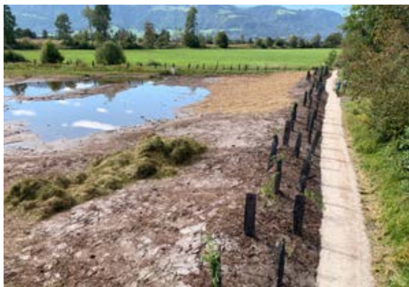
Abb. 2: Nach Einbau Torf; Schnittgut als zusätzlicher Schutz liegt bereit.
