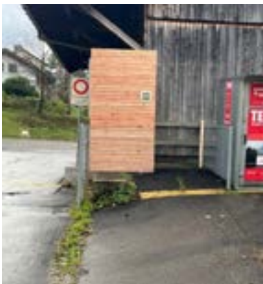
Neu installiert: Öffentliche Toilette beim Bahnhof Schänis.
