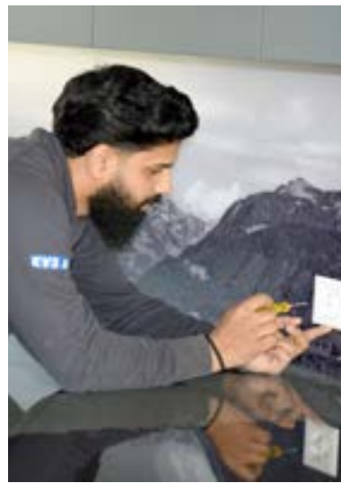
Elektroinstallationen Überbauung Breite.
